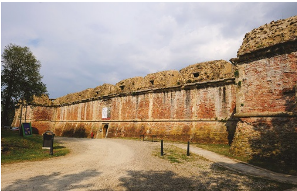
Fortaleza de Poggio Imperiale en Poggibonsi.
